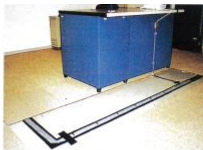
図 平型フロアケーブル配線工法
